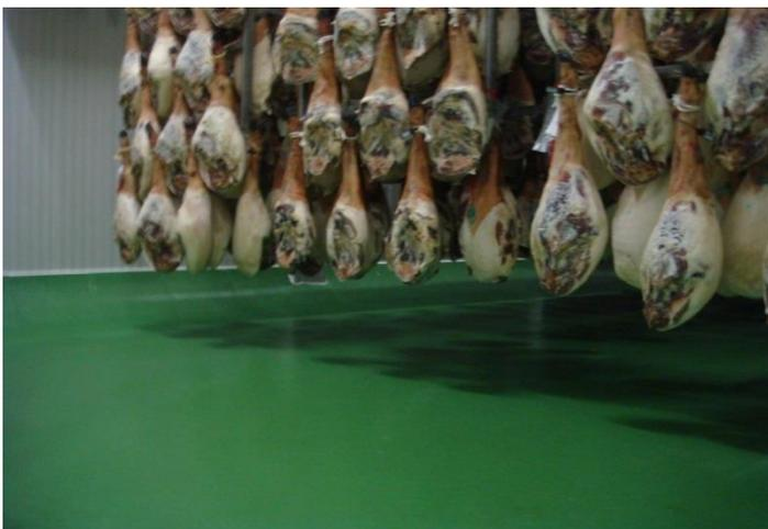
Flowfresh Coating es un revestimiento a base de resinas de poliuretano en espesores de 2 a 3 mm, muy resistente química y físicamente, con un excelente acabado higiénico sanitario incorporando un tratamiento antibacteriano y una rugosidad adaptada a las necesidades que le dota de propiedades antideslizantes.
